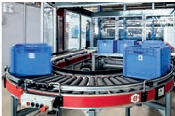
Da steckt Eplan drin: eine Sortieranlage in der Demo-Fabrik am Campus der RWTH Aachen.
