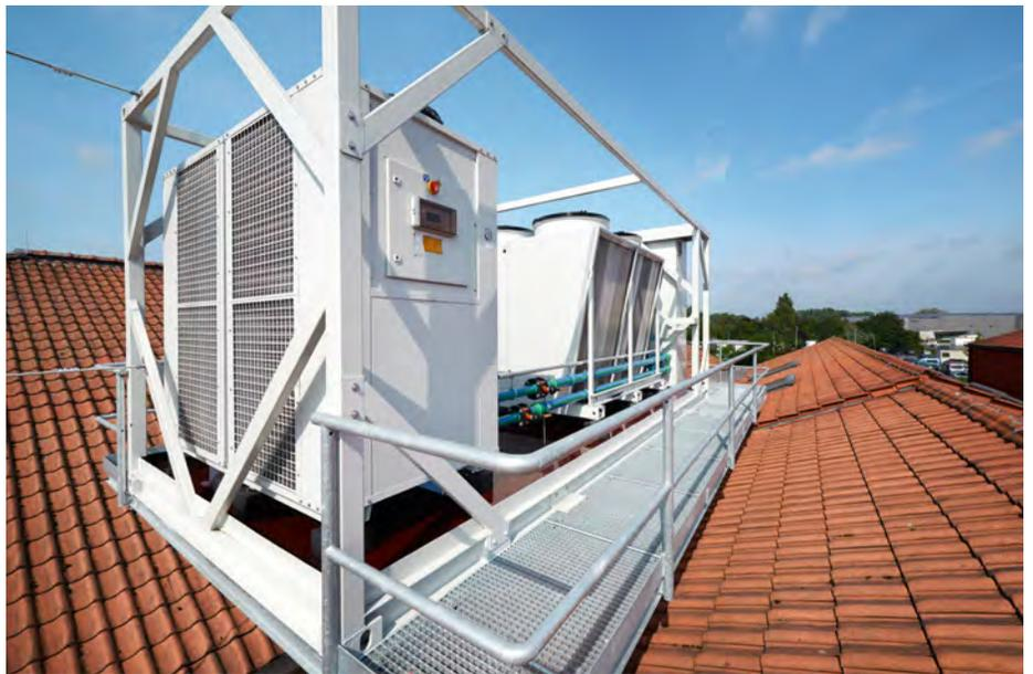
**Eine Freikühlung** – wie hier in einem Kühlcontainer auf dem Dach – ist eine einfache Option, die sich schnell rentiert.
