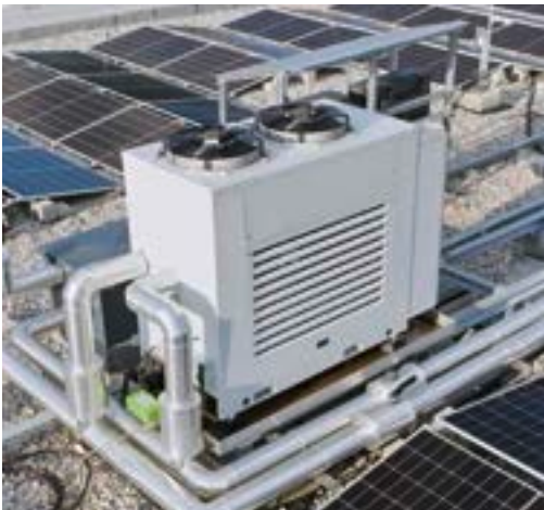
Auf dem Dach installierte Rittal einen Chiller, um für Notfälle gerüstet zu sein.
